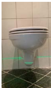
Manglende drenshull/synliggjøring av lekkasje fra veggmontert sistene.
