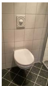
Manglende drenshull/synliggjøring av lekkasje fra veggmontert sistene.
