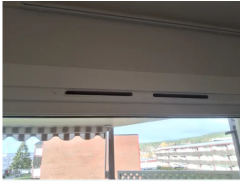
Naturlig ventilasjon med spalter i vinduer.
