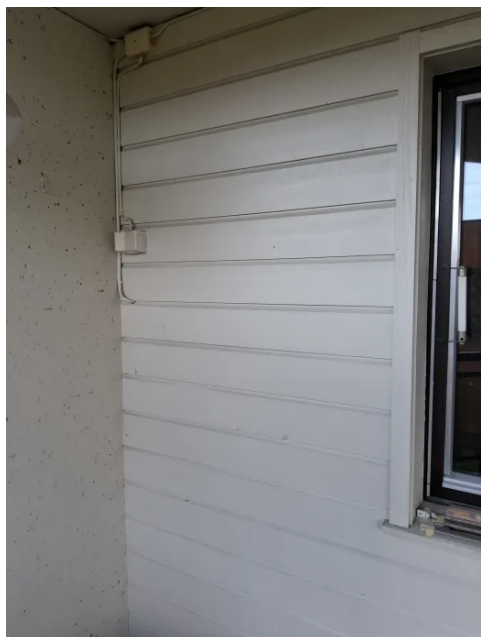
Yttervegg på balkong er kledd med liggende trekledning.
