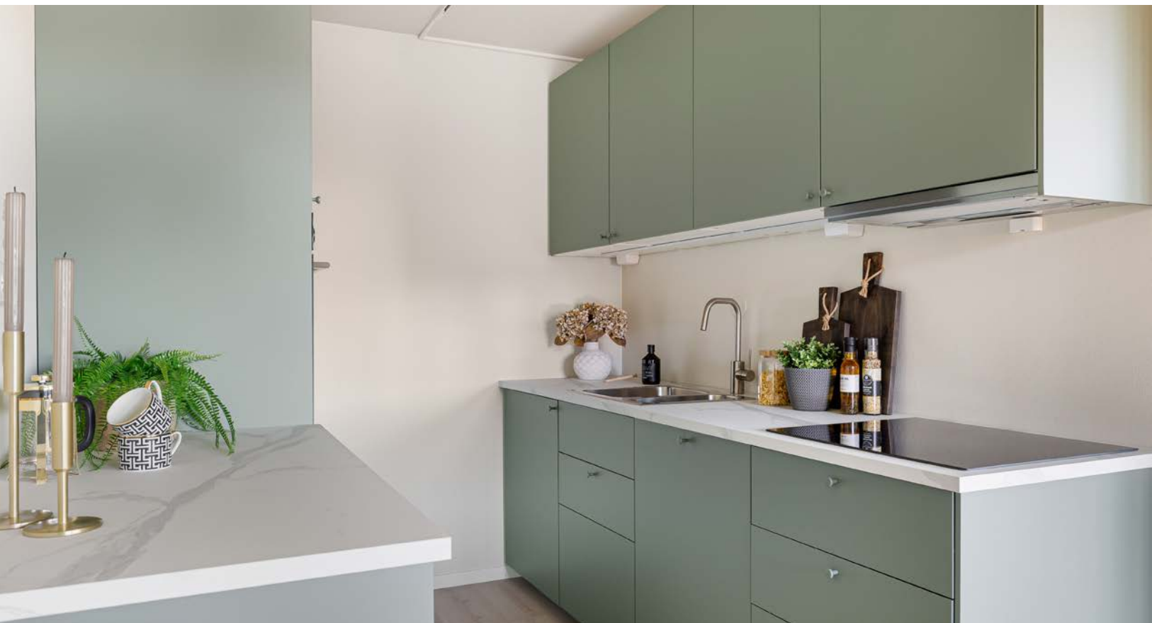
Benkeplate av laminat med nedfelt oppvaskkum med liten skyllekum i rustfritt stål.
