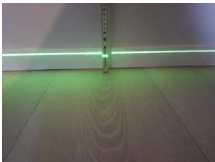
Etasjeskillet er kontrollert med nivelleringslaser.
