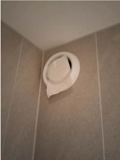
Avtrekkseffekten er testet med papir.
