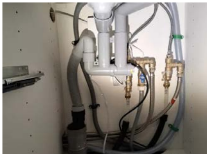
Leiligheten har synlige avløpsrør av plast.
