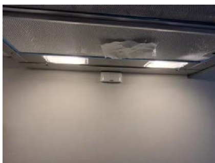
Avtrekkseffekten er testet med papir.
