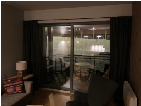
Heve/skyvedør i stue.
