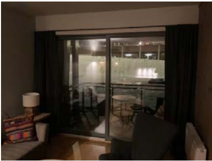
Heve/skyvedør i stue.
