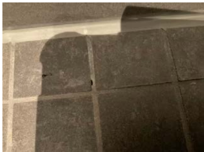
Hull i fugemasse på gulv.
