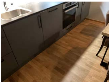
Området for fuktsøk.
