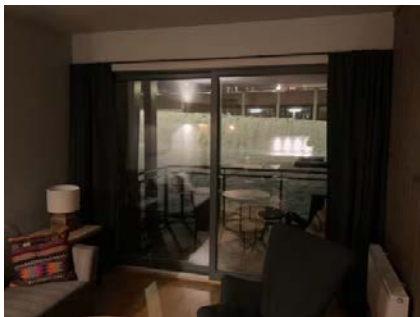
Heve/skyvedør i stue.
