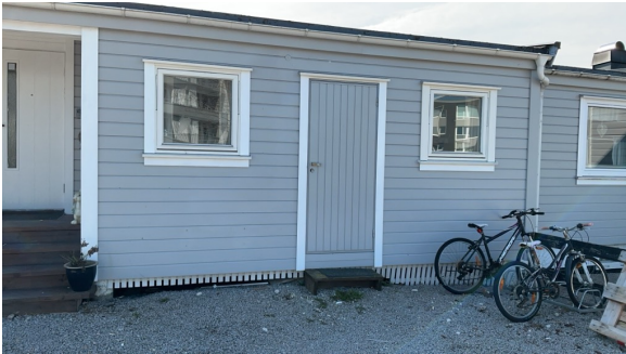
Dør som er igjennbygget på innsiden.
