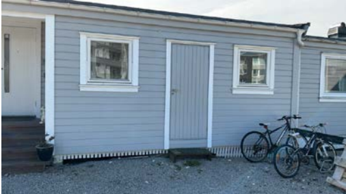
Dør som er igjennbygget på innsiden.
