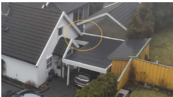
Bildet viser at tidligere frittliggende carport med bod, nå er bygget sammen med bolig.
