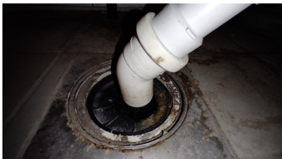
Kontroll av sluk under badekaret.
