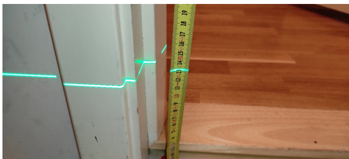
Kontroll av fall mot sluk.
