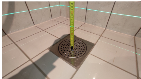
Kontroll av fallforhold.
