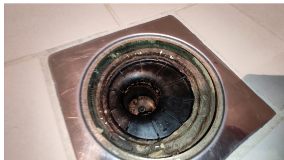
Kontroll av sluk i dusjnisjen
