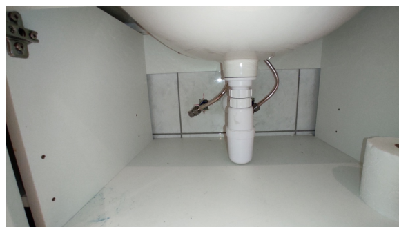
Kontroll av røropplegg.
