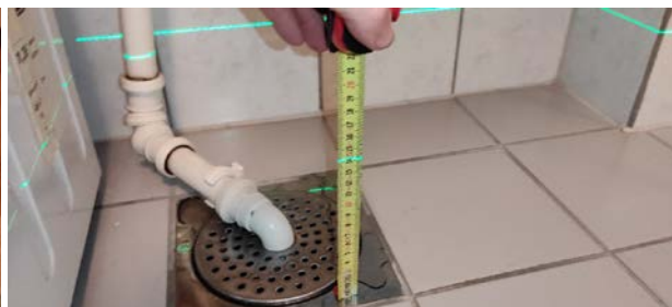
Kontroll av fall mot sluk.
