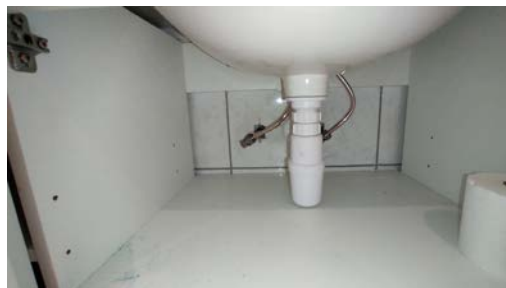
Kontroll av røropplegg.
