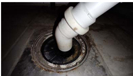
Kontroll av sluk under badekaret.
