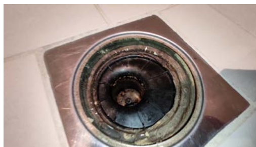
Kontroll av sluk i dusjnisjen
