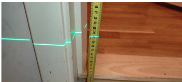
Kontroll av fall mot sluk.
