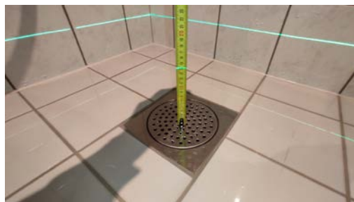
Kontroll av fallforhold.
