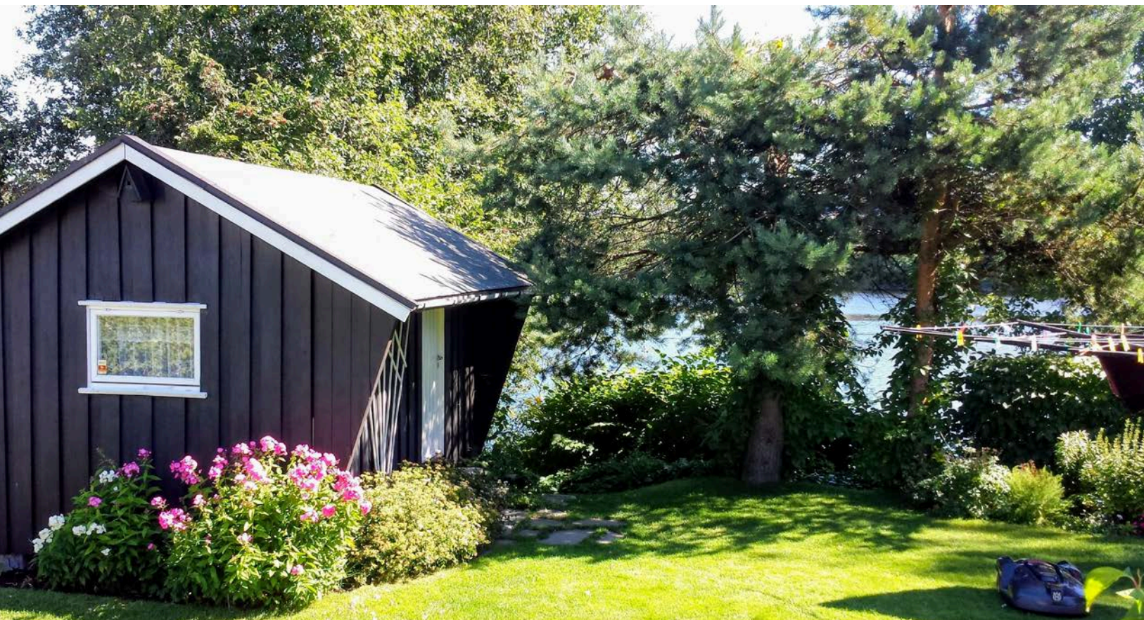
Isolert anneks. Foto fra selger.
