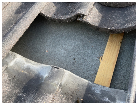
Undertak av tjærepapp.
