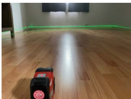
Måling av gulver.
