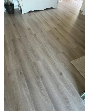
Del av gulv som er lagt nytt i 2023/2024.
