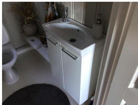
Montert innredning med håndvask.
