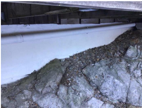
Del av grunnmur.
