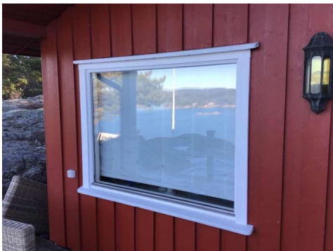
Eksempel på vindu montert i vegg.
