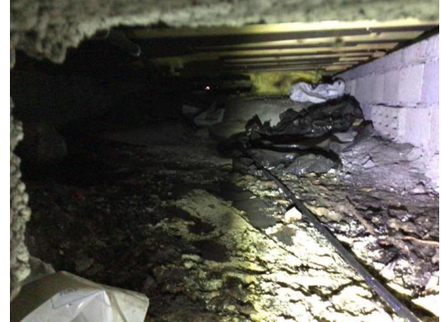
Del av krypkjeller.
