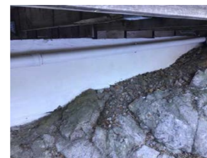
Del av grunnmur.
