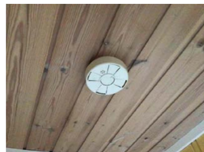
Montert røykvarsler i tak.
