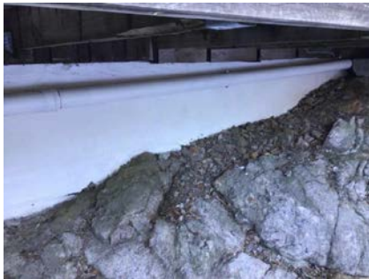
Del av grunnmur.
