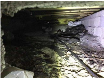
Del av krypkjeller.
