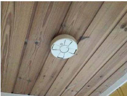
Montert røykvarsler i tak.
