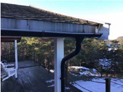
Del av takrennesystem.
