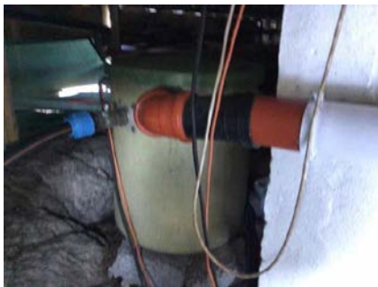
Del av avløpsrør og pumpe kum til kloakk inn på offentlig nett.
