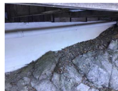
Del av grunnmur.
