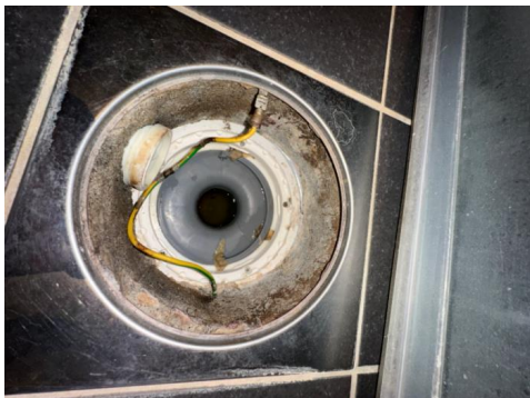
Plastsluk med klemring for membran
