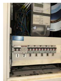
Sikringsskap plassert i felles oppgang.
