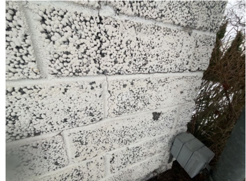
Sprekk lecamur glassveranda
