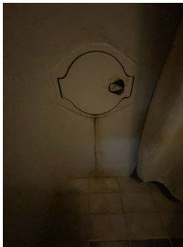
Provisorisk tettet røykrørsinnføring
