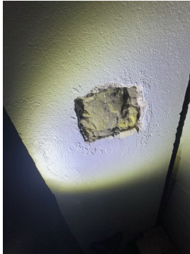
Provisorisk tettet røykrørsinnføring
