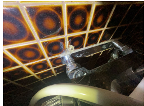
Avskall/sprekk flis
