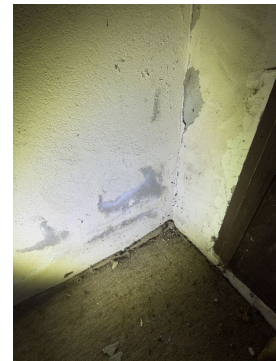
Fuktsøk økende mot gulv (kapilærøpsug)
