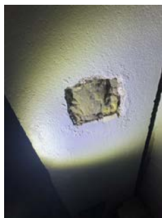
Provisorisk tettet røykrørsinnføring
