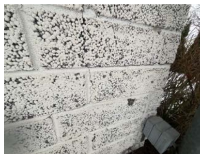
Sprekk lecamur glassveranda
