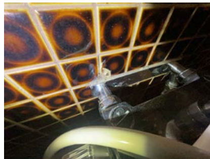
Avskall/sprekk flis
