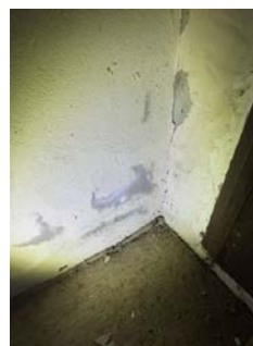
Fuktsøk økende mot gulv (kapilærropsug)
