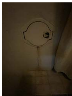
Provisorisk tettet røykrørsinnføring
