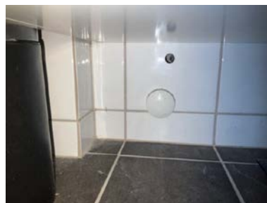
Drenering for toalettet.
