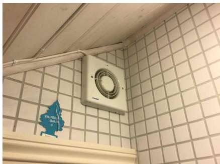
Montert avtrekk i bad.
