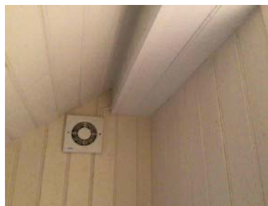
Montert avtrekk i tilstøtende rom.
