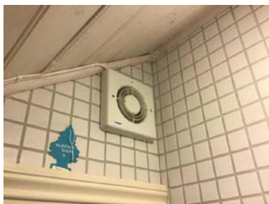
Montert avtrekk i bad.
