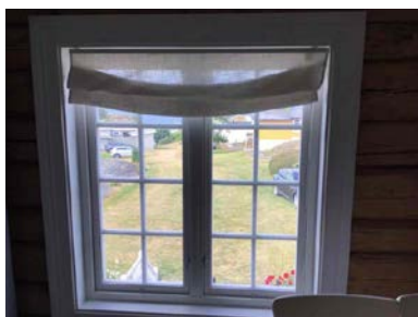
Eksempel på vindu i yttervegg, sett fra innsiden.
