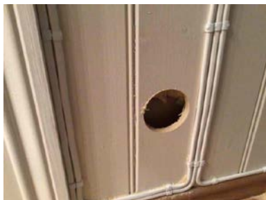
Hull for kontroll av fukt.
