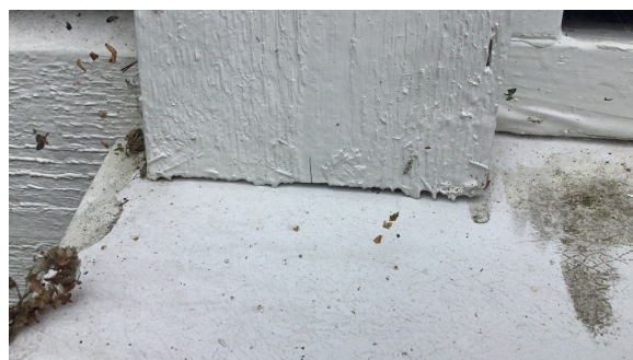
Omramming er ført helt ned til vannbrett.
