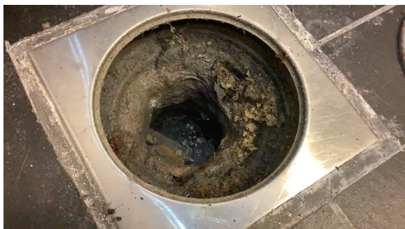
Plastsluk uten synlig tettesjikt.
