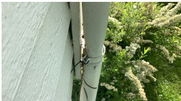
Klemskadet nedløpsrør.
