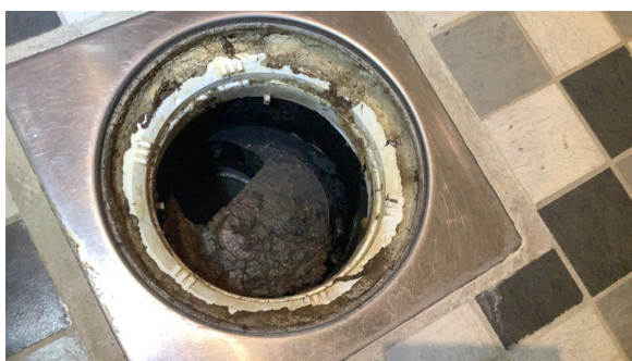
Plastsluk, uten synlig tettesjikt.
