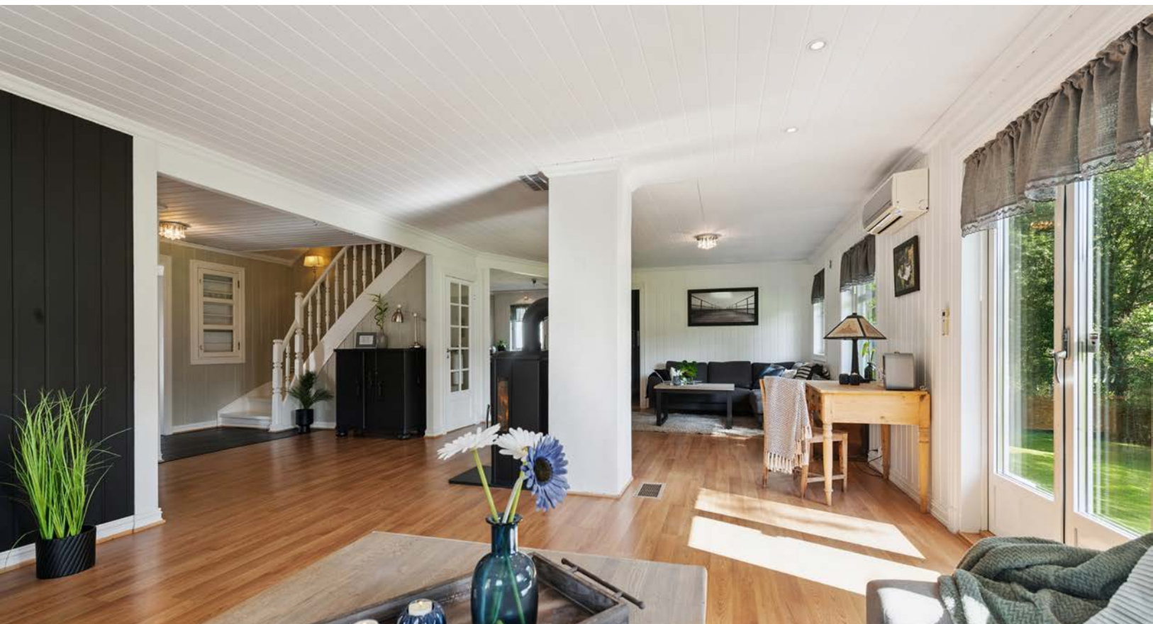
I stuen er det en luft til luft varmepumpe, som gir god varme i 1. etasje.
