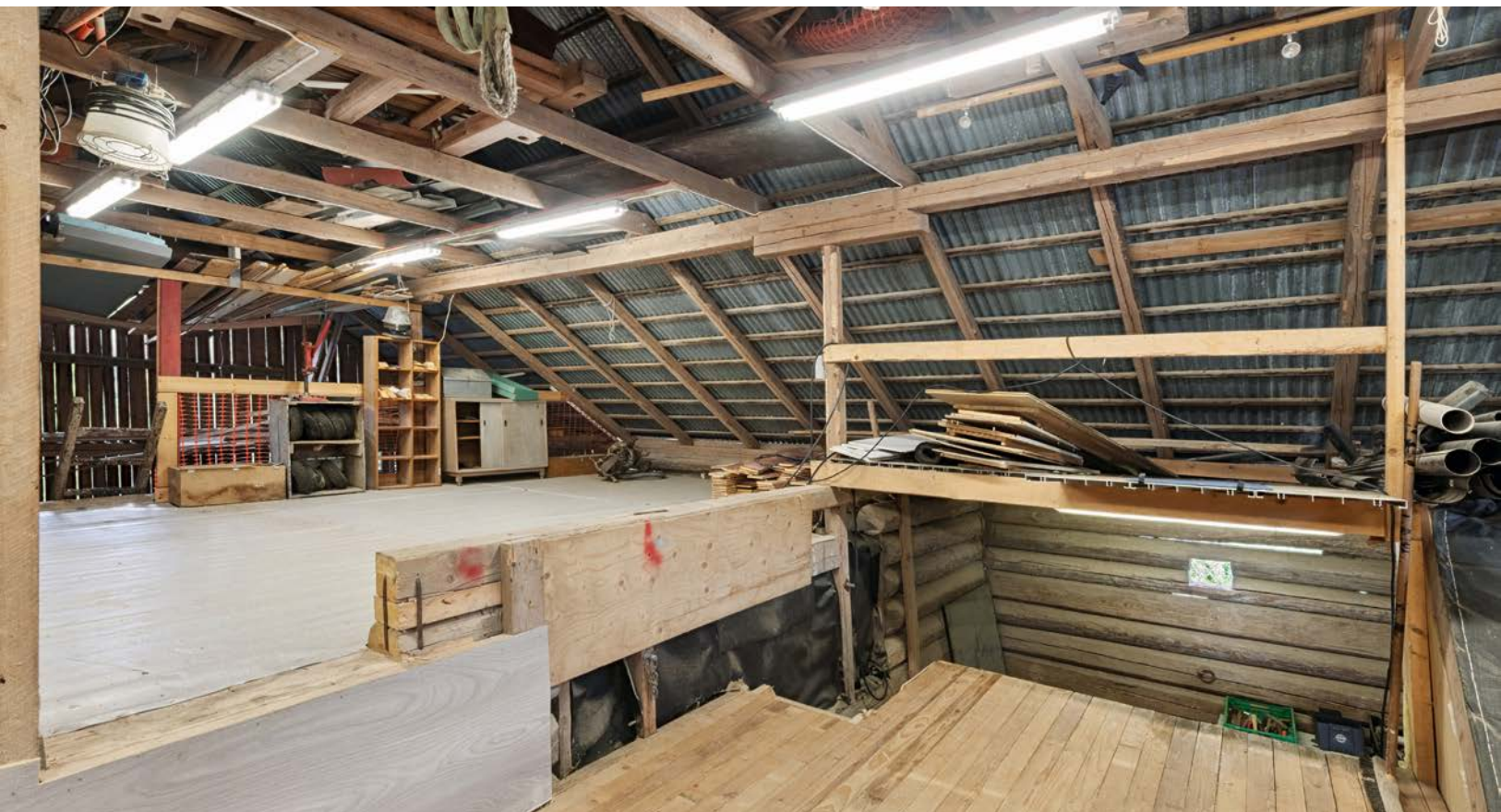
2. etasje i verkstedbygg
