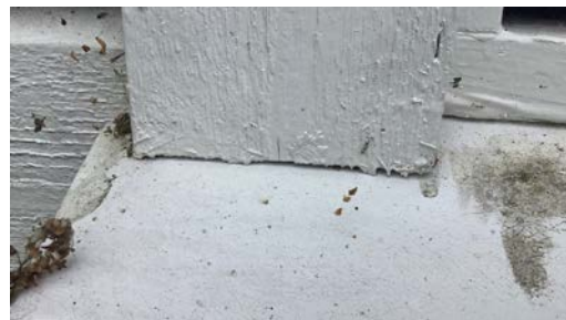
Omranning er ført helt ned til vannbrett.
