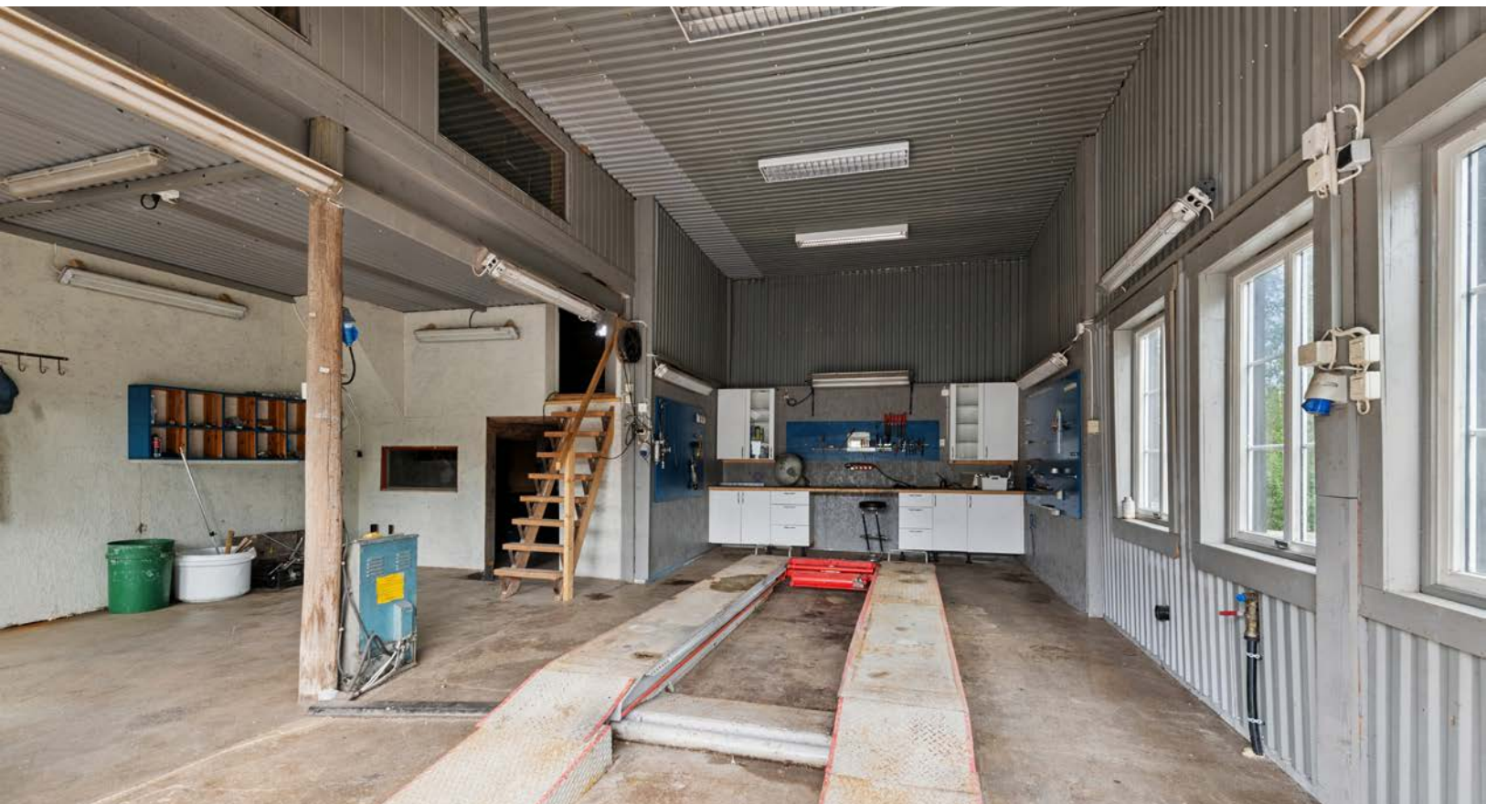
Isolert verksted med stor takhøyde innvendig. Det er montert løftebukk.
