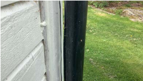
Frostsprengt nedløpsrør.
