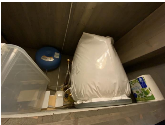
Besiktigelse av bereder.
