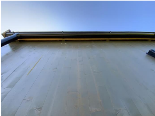
Synlige luftespalter i gesimskasser.
