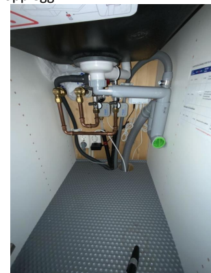
Besiktigelse av røropplegg.
