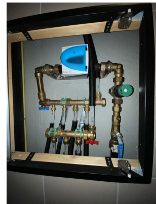
Besiktigelse av røropplegg.
