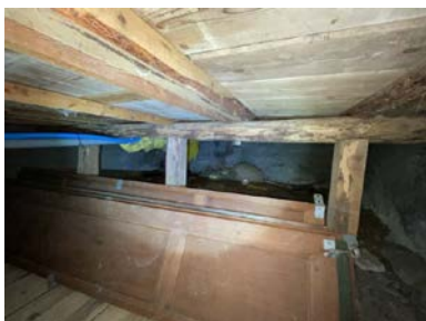
Høye fuktverdier i trevegg.
