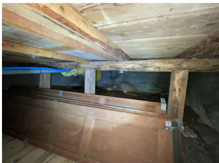
Høye fuktverdier i trevegg.
