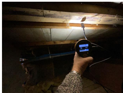
Det ble målt med pigg i stubbloft, og det ble ikke indikert noen unormale høye fuktverdier på befaringstidspunktet.
