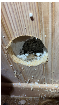
Hulltaking foretatt i innforet/innredet rom som er kjellerstue i vegg mot ytermur, ved fuktmåletaking var det fuktutslag
