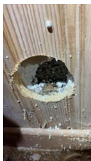
Hulltaking foretatt i innforet/innredet rom som er kjellerstue i vegg mot yttermur, ved fuktmåletaking var det fuktutslag
