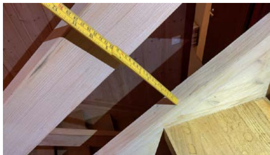
Åpning i rekkverk er over krav
