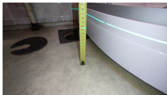
Kontroll av fallforhold.
