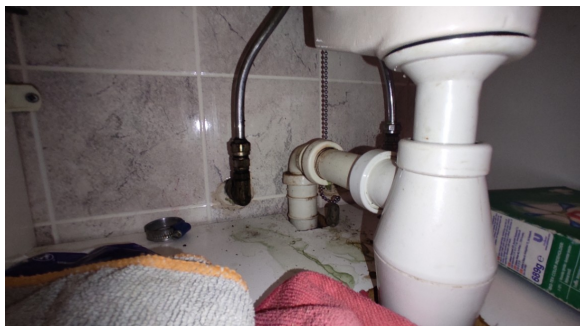
Kontroll av røropplegg.
