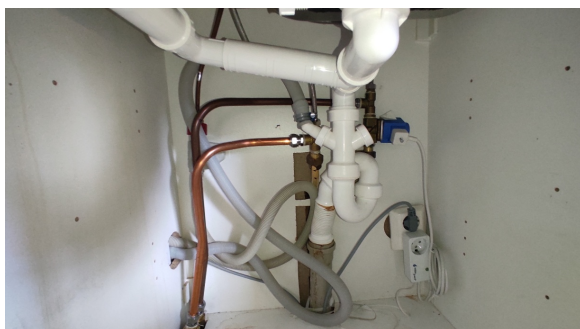
Kontroll av røropplegg.
