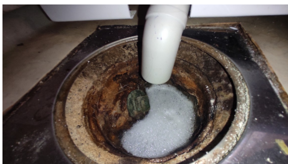
Kontroll av sluk.
