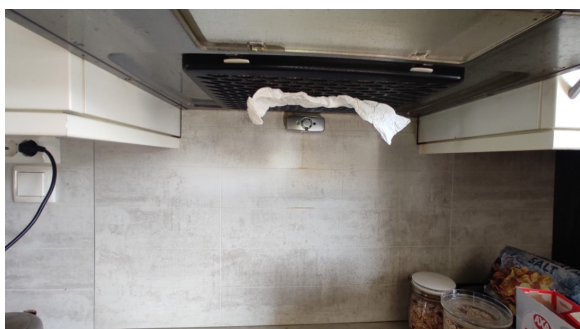
Test av avtrekket.
