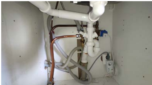
Kontroll av røropplegg.
