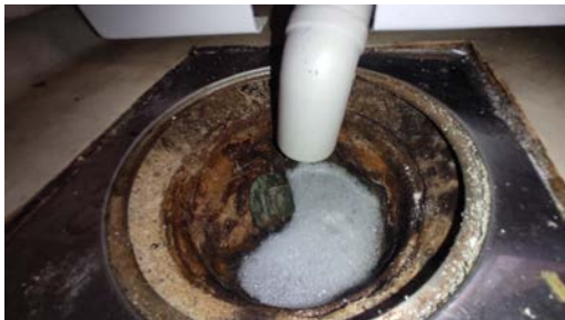
Kontroll av sluk.
