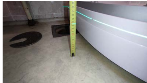
Kontroll av fallforhold.
