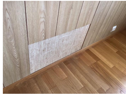
Utsparing i veggkledning i stue.
