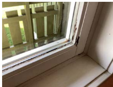
Eksempel på innvendig slitasje.
