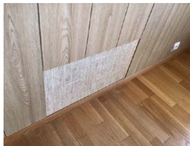
Utsparing i veggkledning i stue.
