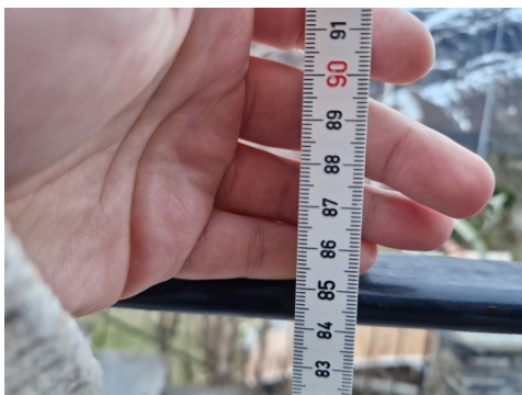
Rekkverk er målt til ca.85 cm.
