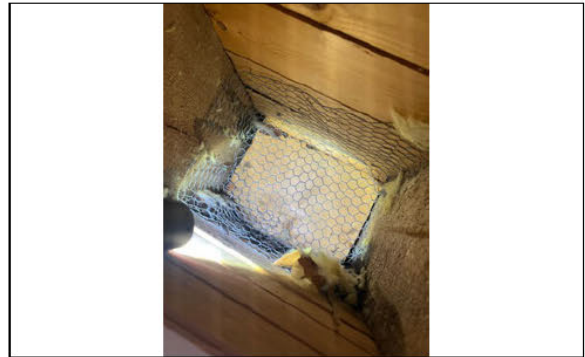
Netting som er etablert mellom bjelkene i etasjeskiller.
