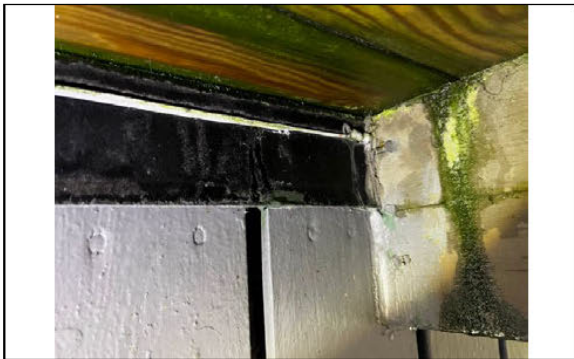
Utvendig beslag i overgang/underkant av balkong.
