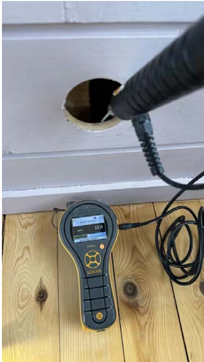
hulltaking fra gang
