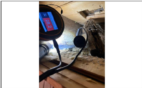
Fuktmåling i bjelke, måling gjennom luke i bod.
