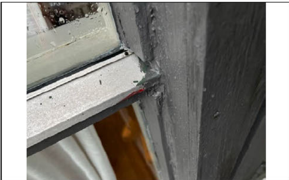
Utvendig fuging på stuevindu.
