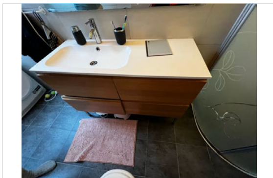
Seksjon på badetrommet hvor blandeblatteriet var skiftet før egen besiktigelse.
