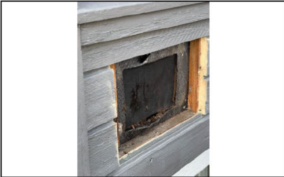
Åpnet del av yttervegg for kontroll av etasjeskillet ut mot yttervegg.
