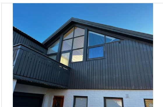
Vindusfelt over entre hvor det er medtatt utskifting vinduer og dør med unntak av 3 vinduer til høyre i bildet.
