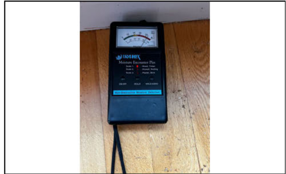
Det avdekkes fukt i parkettgulvet med en fuktindikator.
