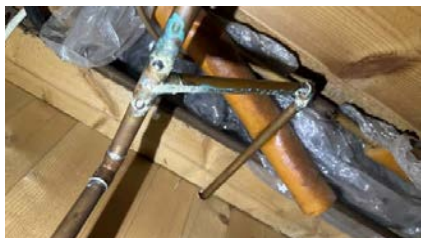
Større iring på røropplegg i bod under trapp
