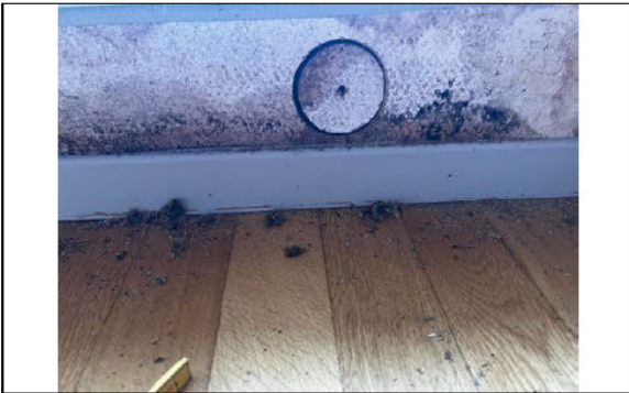
Foto av vegg som viser hulltakingen.
