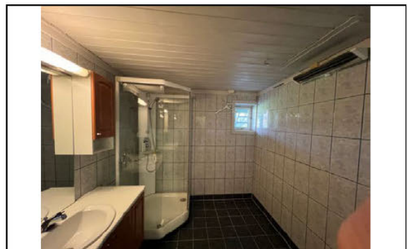
Baderommet i kjeller.
