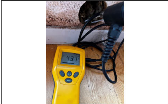
Fuktmåling av bunnsems/yttervegg.
