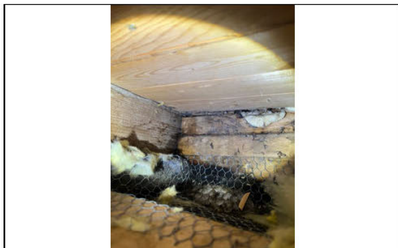
Understøttelsen av søylepunkt mellom vindu og terrassedør.
