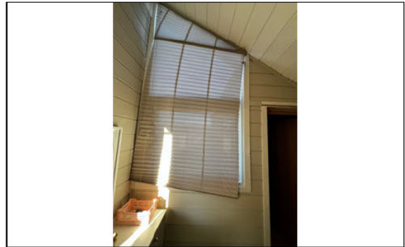
Vinduene i tilstøtende soverom som også er medtatt i kostnadsvurderingen.
