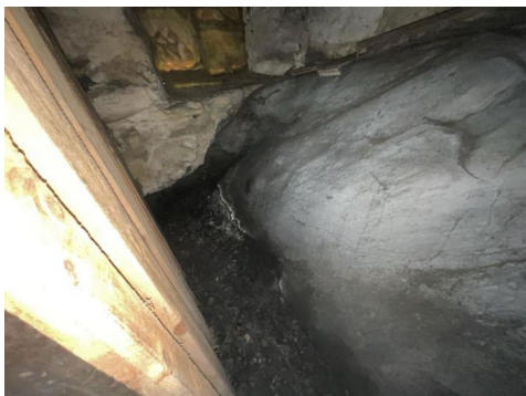
Del av rom under terreng.
