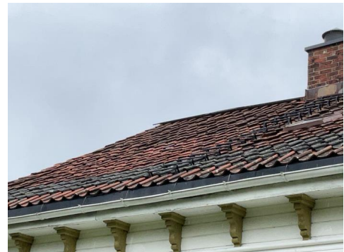
Del av taktekkning.
