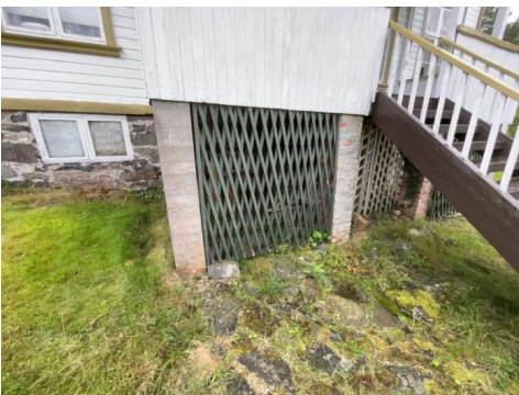
Del av grunnmur.
