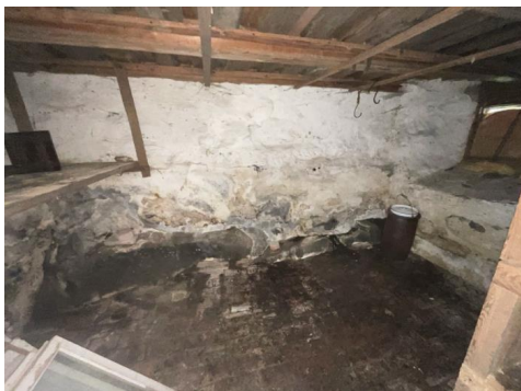
Del av rom under terreng.
