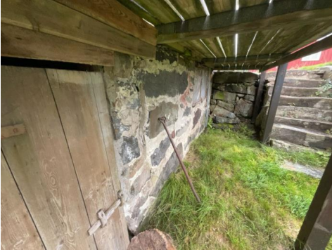
Del av grunnmur.
