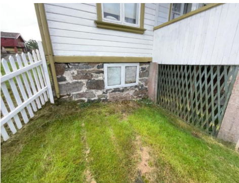
Del av grunnmur.
