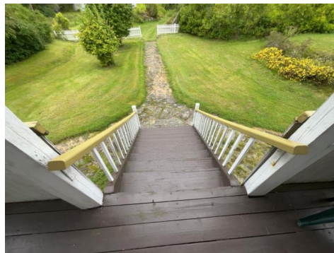
Trapp ned fra terrasse.
