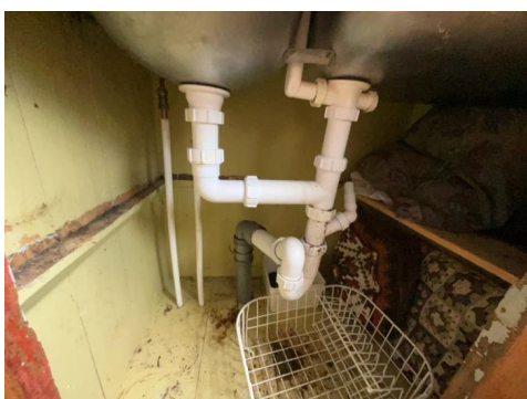
Del av rør til avløp.
