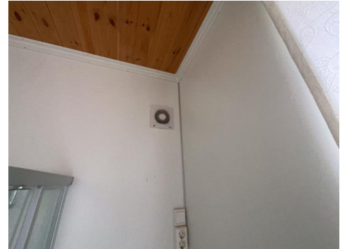
Montert avtrekk i vegg.
