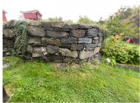
Del av forstøtningsmur.
