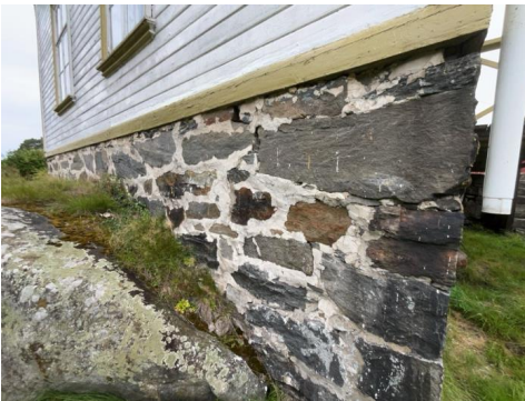
Del av grunnmur.
