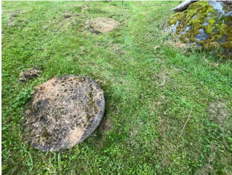
Kum der pumpeanlegg er montert.
