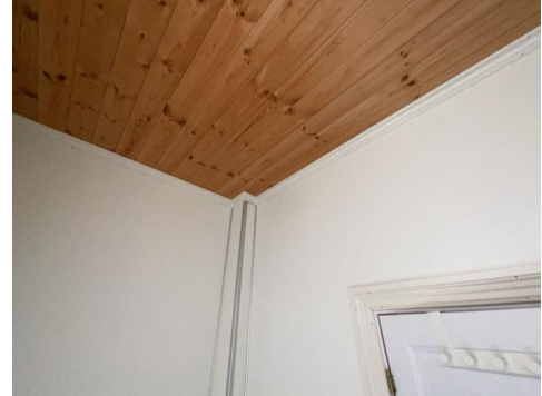
Del av vegg - tak.
