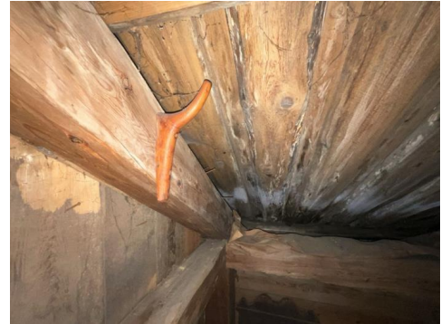
Del av takkonstruksjon, sett fra loft.
