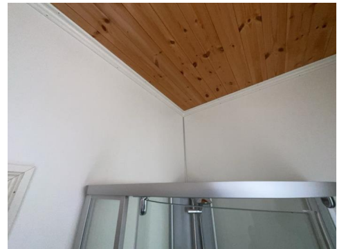
Del av vegg - tak.
