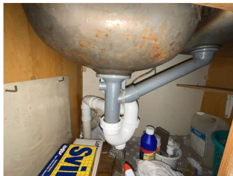
Del av rør til avløp.
