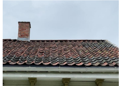
Del av taktekkning.
