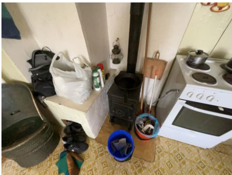
Montert ovn i kjøkken 1 etasje.
