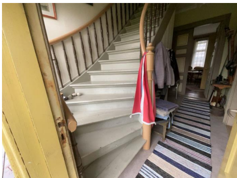
Trapp opp til 2 etasje.
