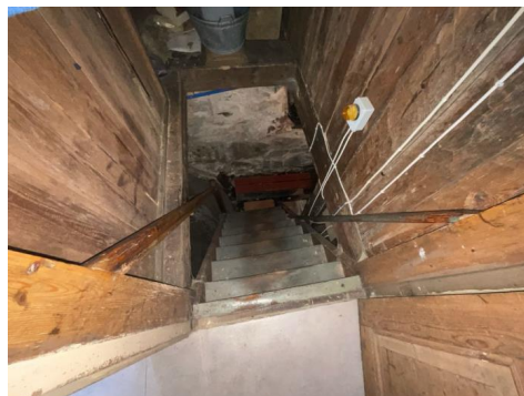
Trapp ned til kjeller.
