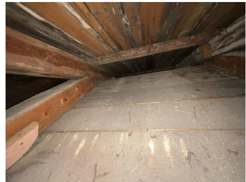
Del av takkonstruksjon, sett fra loft.
