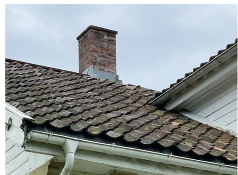
Del av taktekkning.
