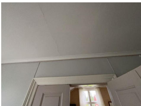
Del av vegg - tak.
