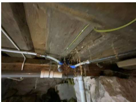
Del av rør til vann.
