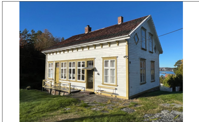
Bilde tatt på befaring 14.10.2025.
