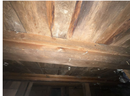
Del av etasjeskille sett fra undersiden.
