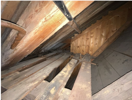
Del av takkonstruksjon, sett fra loft.
