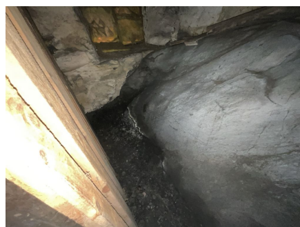
Del av rom under terreng.
