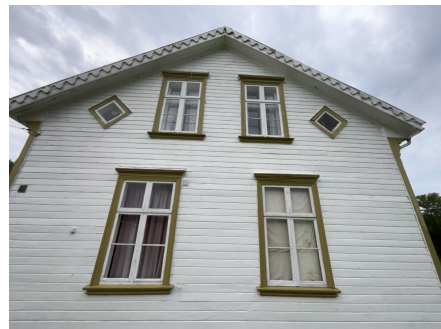
Eksempel på vinduer i yttervegg.
