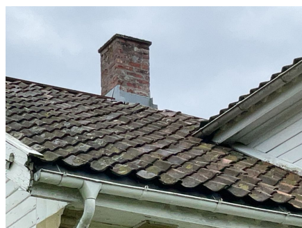
Del av taktekking.
