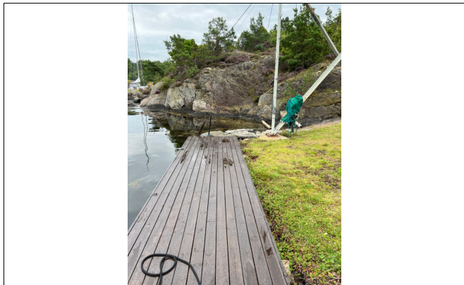
Del av brygge nord/øst på eiendommen.
