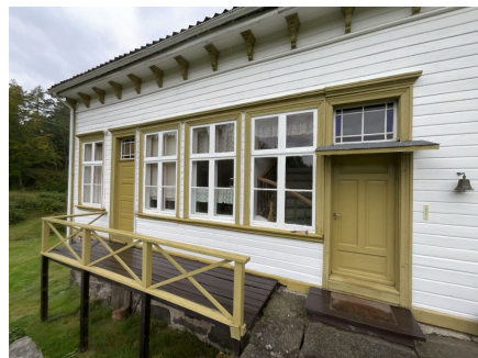
Hovedinngangsdør. Dør til venstre er ikke bruk.
