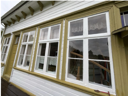
Eksempel på vinduer i yttervegg.
