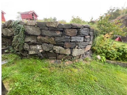
Del av forstøtningsmur.
