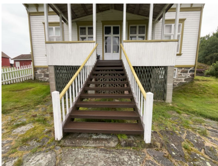
Trapp opp til terrasse.
