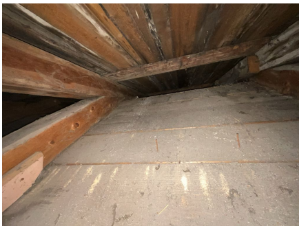
Del av takkonstruksjon, sett fra loft.
