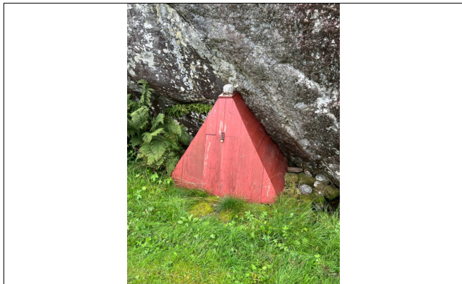
Brønnhus satt opp på eiendommen.
