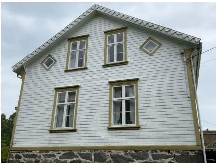
Eksempel på vinduer i yttervegg.
