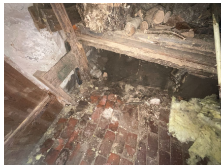
Del av rom under terreng.
