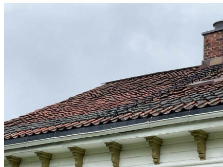
Del av taktekking.
