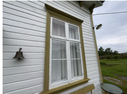
Eksempel på vindu i yttervegg.
