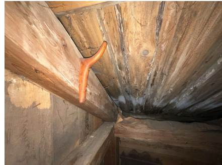
Del av takkonstruksjon, sett fra loft.
