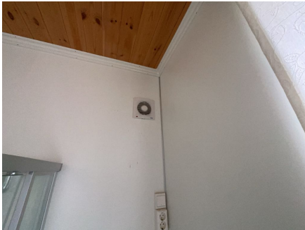
Montert avtrekk i vegg.
