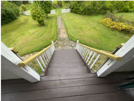
Trapp ned fra terrasse.
