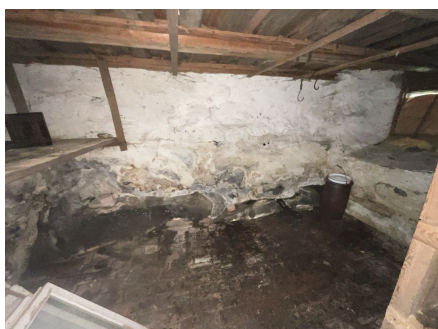
Del av rom under terreng.
