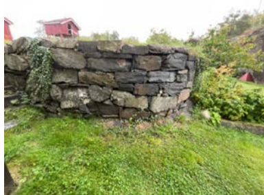
Del av forstøtningsmur.
