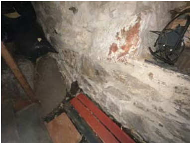
Del av rom under terreng.
