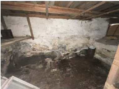
Del av rom under terreng.
