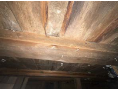
Del av etasjeskille sett fra undersiden.
