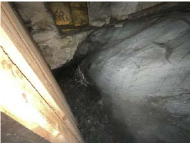
Del av rom under terreng.
