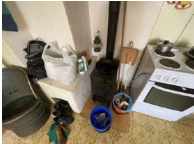
Montert ovn i kjøkken 1 etasje.
