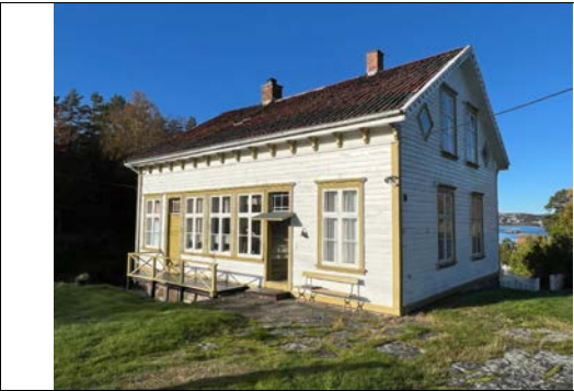
Bilde tatt på befaring 14.10.2025.
