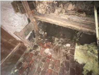
Del av rom under terreng.
