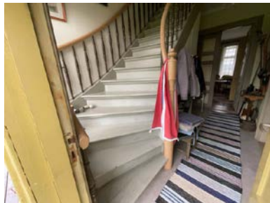
Trapp opp til 2 etasje.
