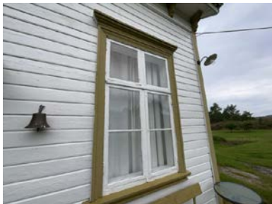
Eksempel på vindu i yttervegg.
