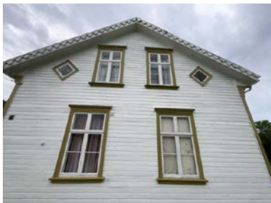
Eksempel på vinduer i yttervegg.
