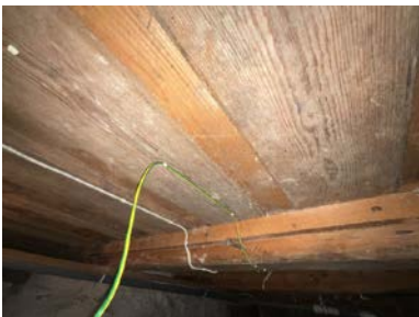
Del av etasjeskille sett fra undersiden.
