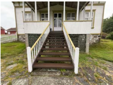
Trapp opp til terrasse.
