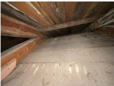
Del av takkonstruksjon, sett fra loft.
