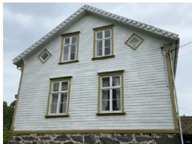
Eksempel på vinduer i yttervegg.
