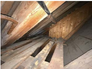
Del av takkonstruksjon, sett fra loft.
