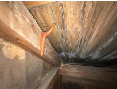
Del av takkonstruksjon, sett fra loft.
