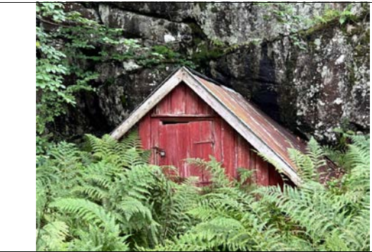
Brønnhus satt opp på eiendommen.
