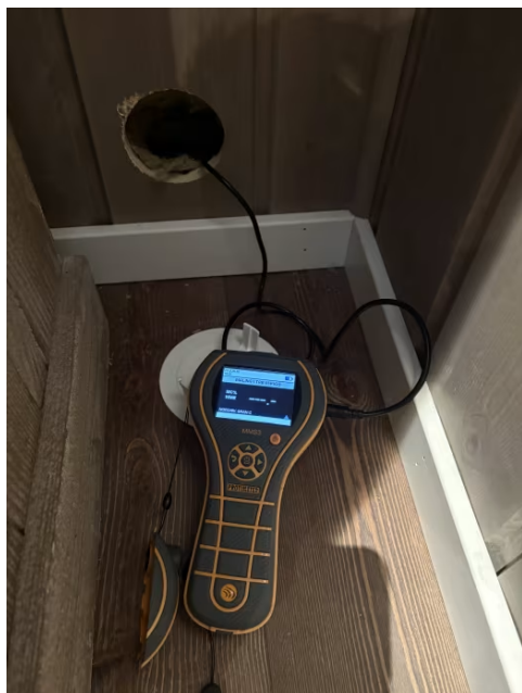
Hulltaking i tilstøtende rom.
