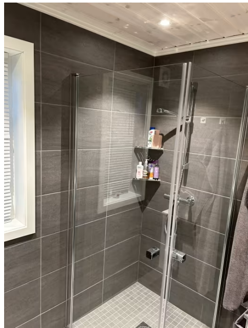
Vindu plassert i våtsone.
