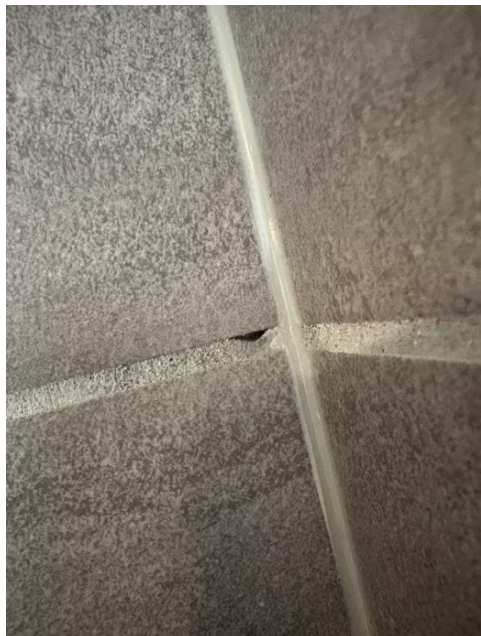
Manglende fugemasse.
