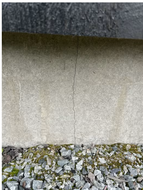
Sprekk i plate utenpå ringmur.
