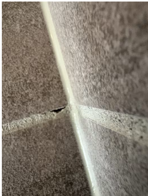
Manglende fugemasse.
