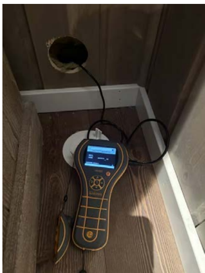
Hulltaking i tilstøtende rom.
