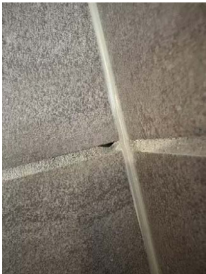
Manglende fugemasse.
