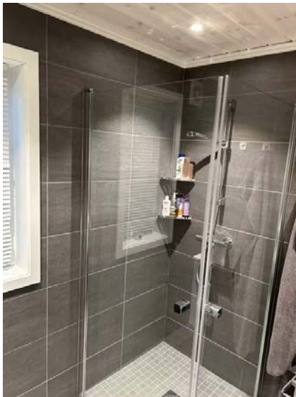
Vindu plassert i våtsone.
