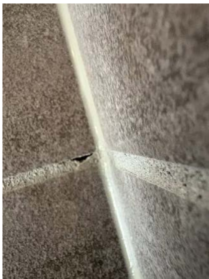
Manglende fugemasse.
