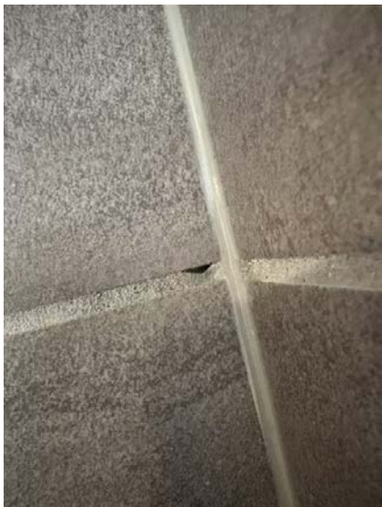
Manglende fugemasse.
