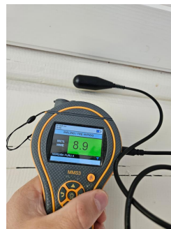
Referansemåling av trefukt i samme stukk ca. 2 meter bortenfor skadestedet.
