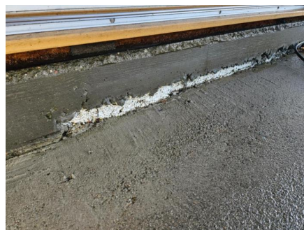
Åpent under dørterskel.
