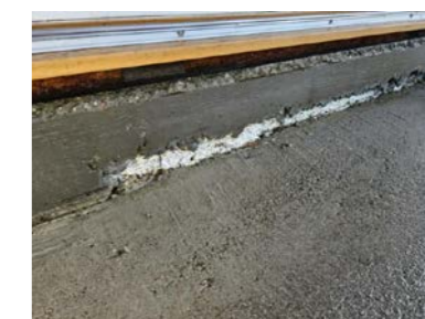
Åpent under dørterskel.
