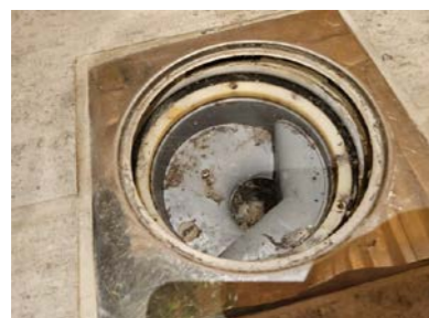
Kontroll av sluk ved tiltenkt dusjsone.
