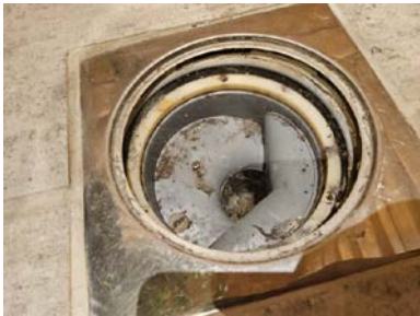
Kontroll av sluk ved tiltenkt dusjsone.
