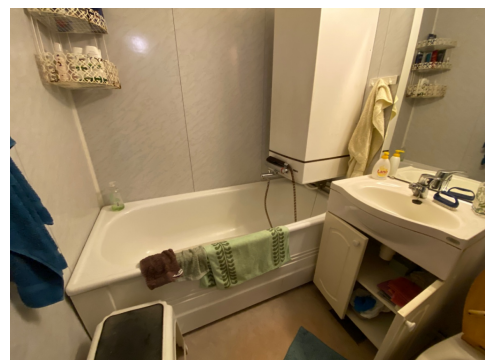
Utette i skjøter på våtromsplater i våtsonen.
