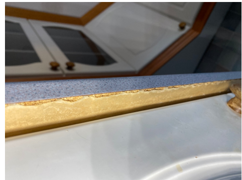
Svellinger under benkeplate foran vasken.
