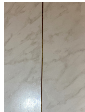
Utette i skjøter på våtromsplater i våtsonen.
