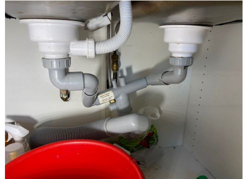
kontroll av røropplegget
