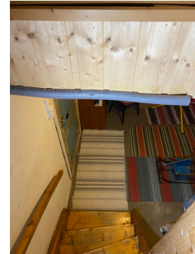
Frihøyde i trapp er målt til ca 1,6 m.
