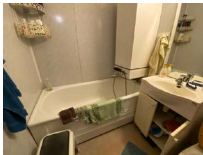
Utette i skjøter på våtromsplater i våtsonen.
