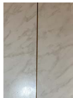
Utette i skjøter på våtromsplater i våtsonen.
