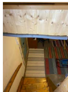
Frihøyde i trapp er målt til ca 1,6 m.
