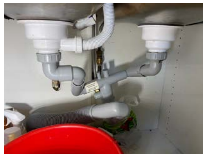
Kontroll av røropplegget
