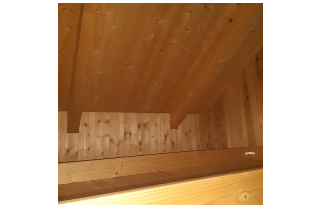
Hems og takkonstruksjon
